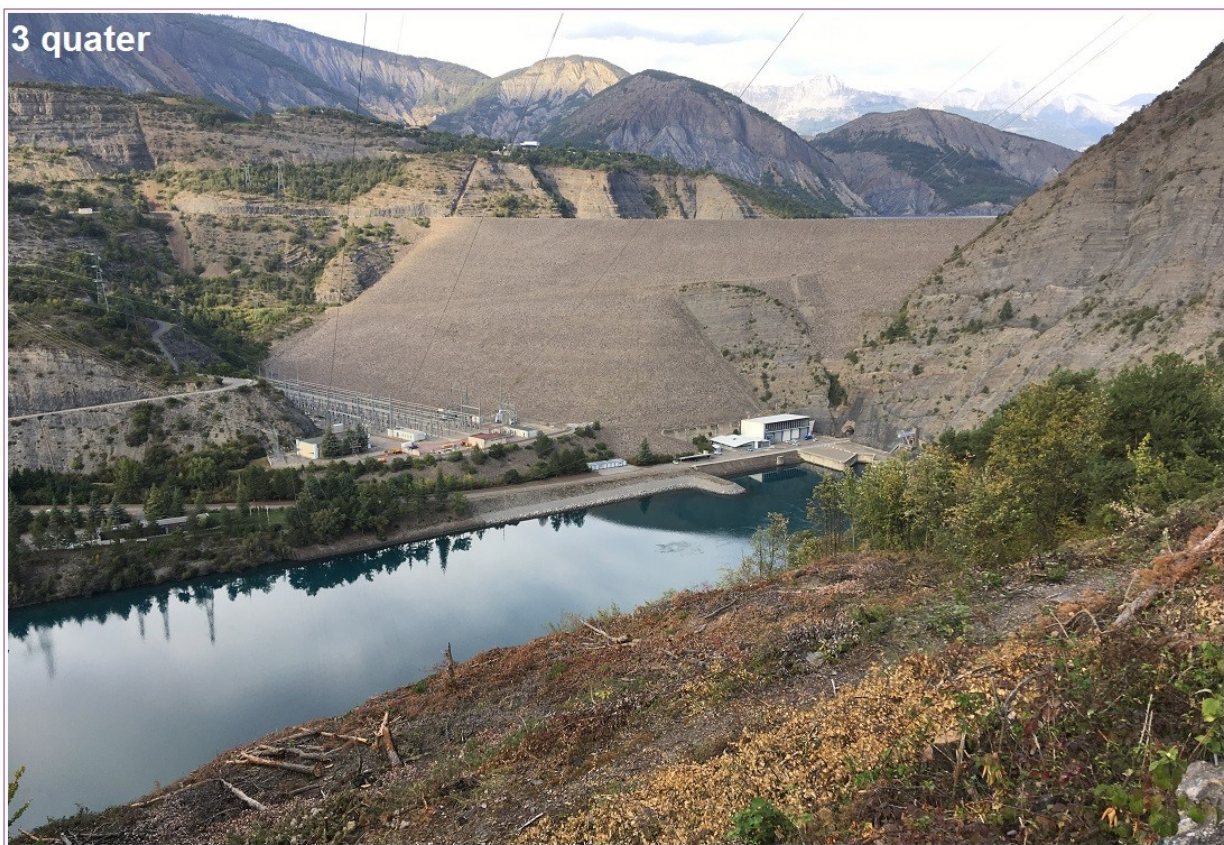
3quater A l'opposé de la photo précédente, vue du barrage de Serre-Ponçon depuis la route Gap / Barcelonnette par une journée calme, c'est à dire sans l'énorme jaillissement qui serait visible à droite si les vannes de vidange de fond étaient ouvertes pour procéder à un lâcher d'eau (21/09/2018).
