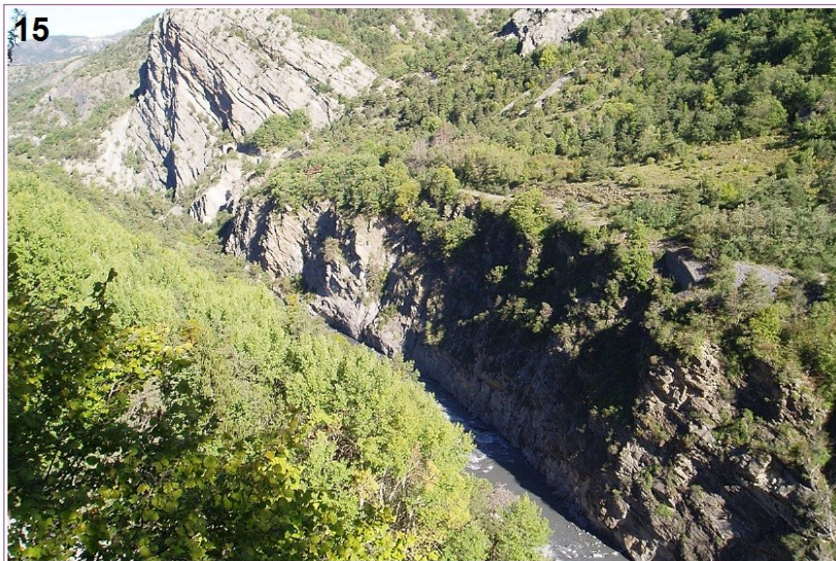
15 A l'approche du Lauzet-Ubaye, depuis la route en rive gauche, un œil averti remarquera, sur la rive opposée, les ouvrages de la ligne qui remonte la vallée de l'Ubaye (ici portail Est du tunnel de Roche Rousse, murs de soutènement...) (2005).
