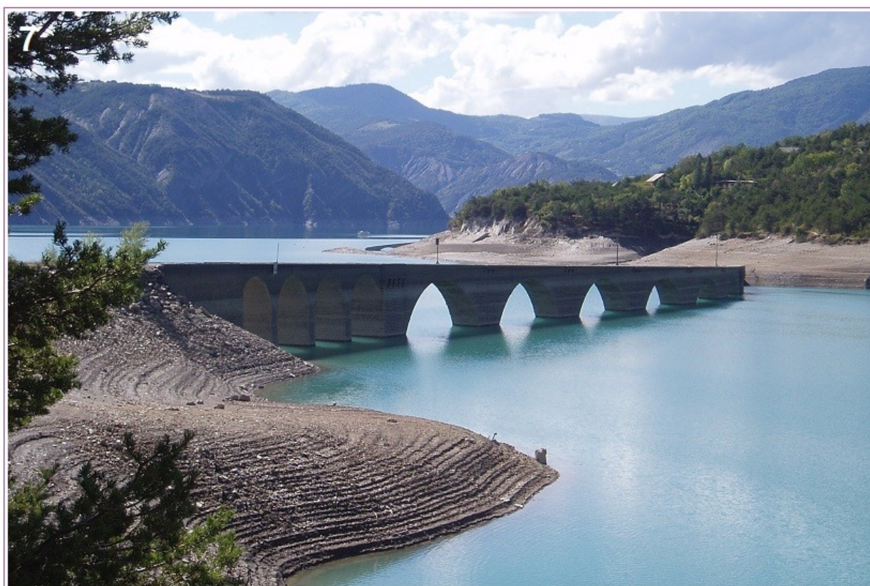
7 Juste après la « bifurcation », la ligne franchit son premier ouvrage d'art : le viaduc de Chanteloube. Il n'a pas été détruit lors de la mise en service du barrage, malgré qu'il puisse présenter une gêne pour l'activité nautique selon le niveau du lac ; mais il en fait aussi son charme (2005).
