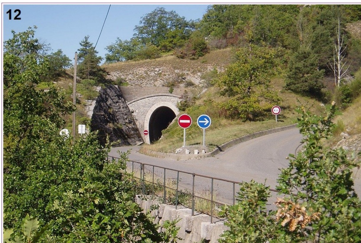
12 Peu après son émergence au-dessus du niveau du lac, la ligne vient recouper la route joignant Le Lauzet-Ubaye à Savines au niveau du tunnel de la Roche, son premier tunnel accessible. En doublement d'un tunnel routier (entrée non visible sur la droite), ce tunnel est réutilisé pour un sens de circulation de la route, ici vue de son portail Est (2005). C'est au niveau du portail Ouest de ce tunnel, juste avant que la ligne ne disparaisse sous les eaux, que mon imagination a positionné la gare fictive de Serre-Ponçon du train touristique TVU « reproduite » sur mon \mu réseau (voir le wagonnet \mu réseau et ci-dessous pages 19 et 20).
