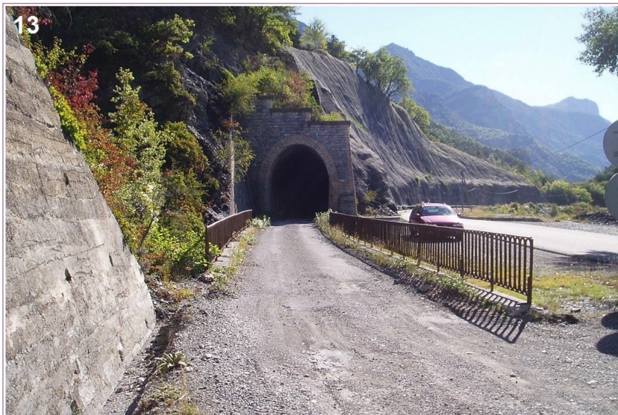
13 Peu après le tunnel de la Roche, le tunnel de Combas a échappé de peu à la destruction, la nouvelle route créée pour contourner le lac a grignoté tout son flanc (2005).
