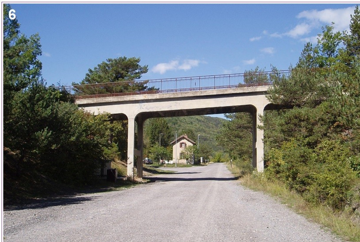
6 A cet endroit, à proximité du centre nautique de Chanteloube, devait se situer l'aiguillage en pleine voie à l'origine de la ligne de Barcelonnnette ; celle-ci se détache, derrière le photographe, vers la gauche, tandis que l'ancienne plateforme de la ligne de Briançon descend vers le lac (2005).
