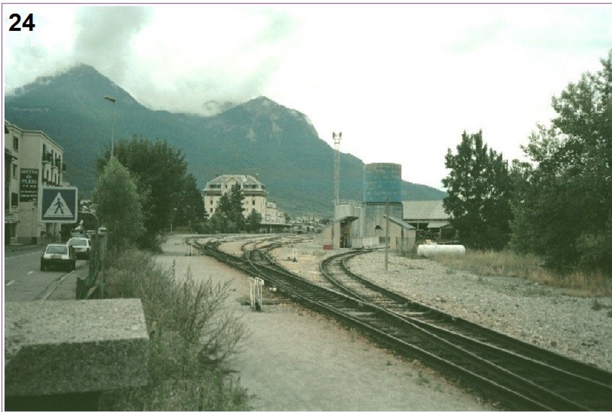
24 A l'extrémité de la gare, le tiroir de manœuvre (derrière le photographe) utilisé pour les remises en tête des locomotives ; de moins en moins utilisé depuis l'arrivée des automoteurs (X72500, AGC...). A cet endroit, le raccordement d'une hypothétique ligne vers l'Italie serait compliqué (2002).
