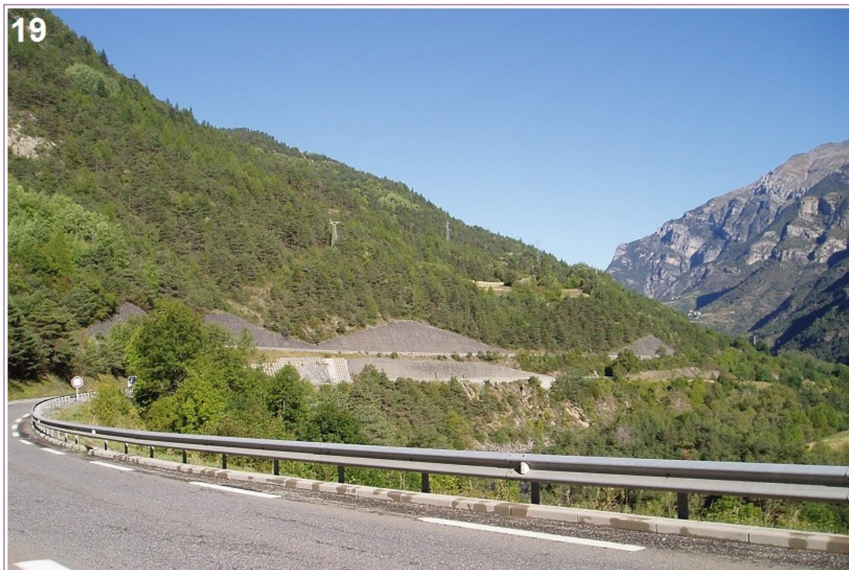
19 Au-delà du Lauzet-Ubaye la ligne (repérable par les murs de soutènement) côtoie la route. Sur certains tronçons, elle est utilisée pour le passage de la voie de circulation routière de sens montant (2005).
